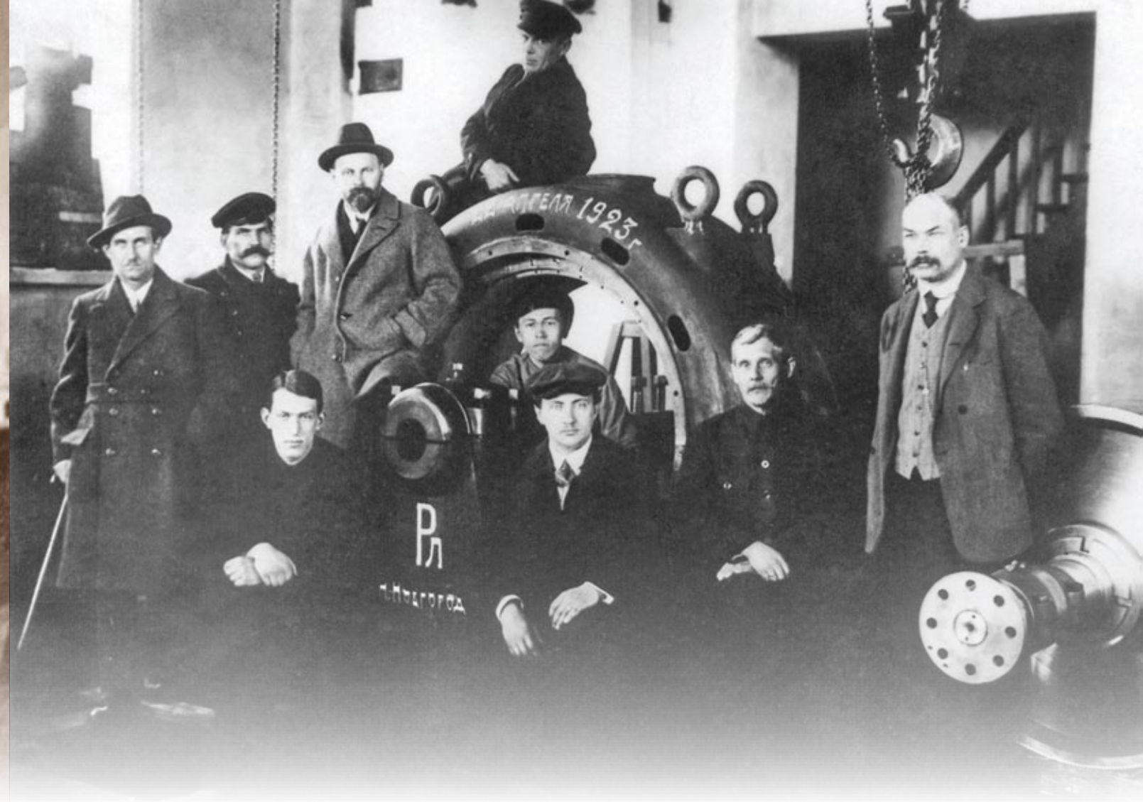
Сотрудники НРЛ (В.П. Вологдин — стоит 3-й слева) возле машины высокой частоты мощностью 50 кВт. 1923 год
