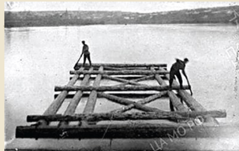
Рамы в собранном виде сплавляются по воде к месту подъема и установки. Мост через р. Южный Буг в районе города Первомайска
