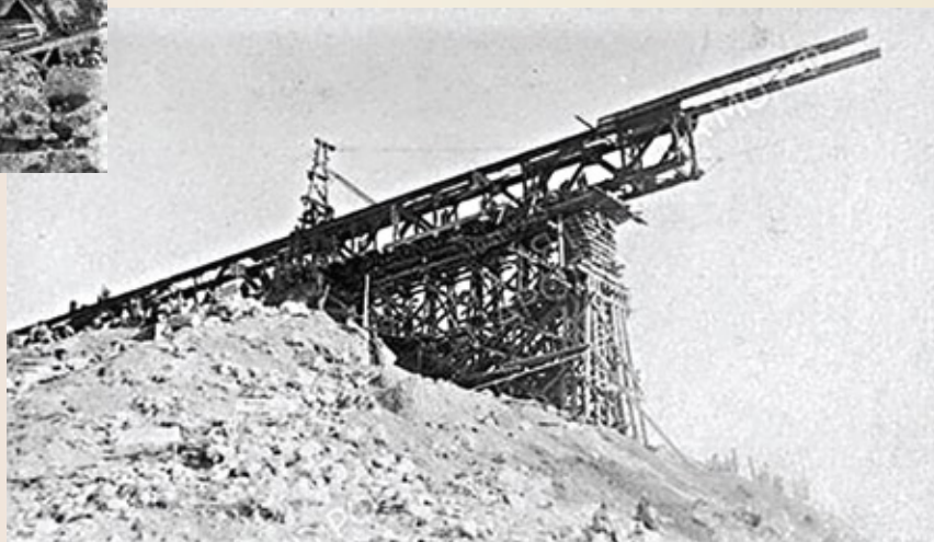
Накатка ферм на мосту через р. Черный Ташлык
