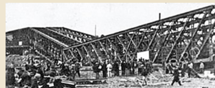
Восстановление моста через р. Лабен
