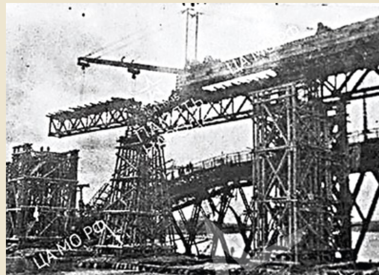
Накатка строений на опору № 3
