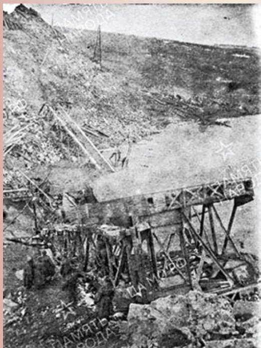
Разрушенный мост через р. Черный Ташлык в районе Ново-Украинки
